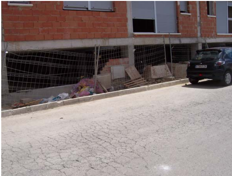
Pavimento calzada deteriorado en c/Cooperativa
