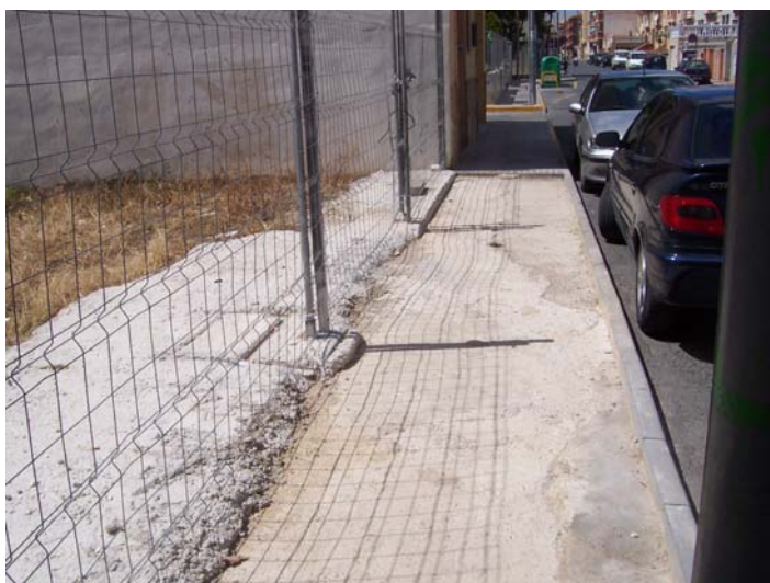
Acera acabada en hormigón
